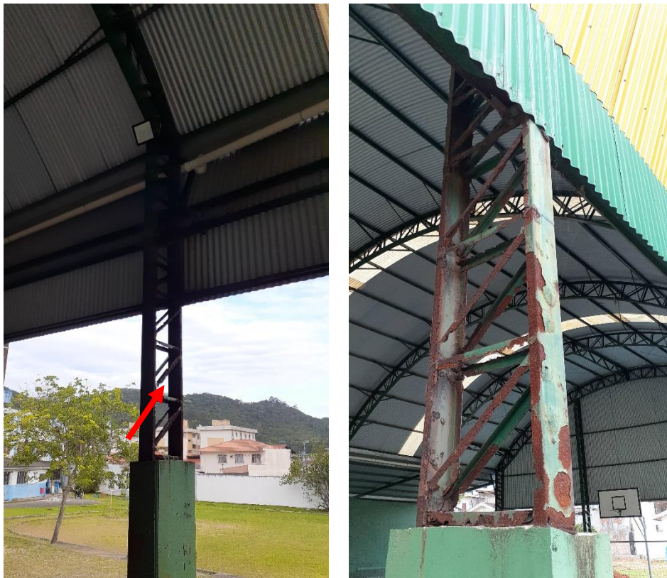
Figura 2 e 3 – Pilar de sustentação em corrosão.
